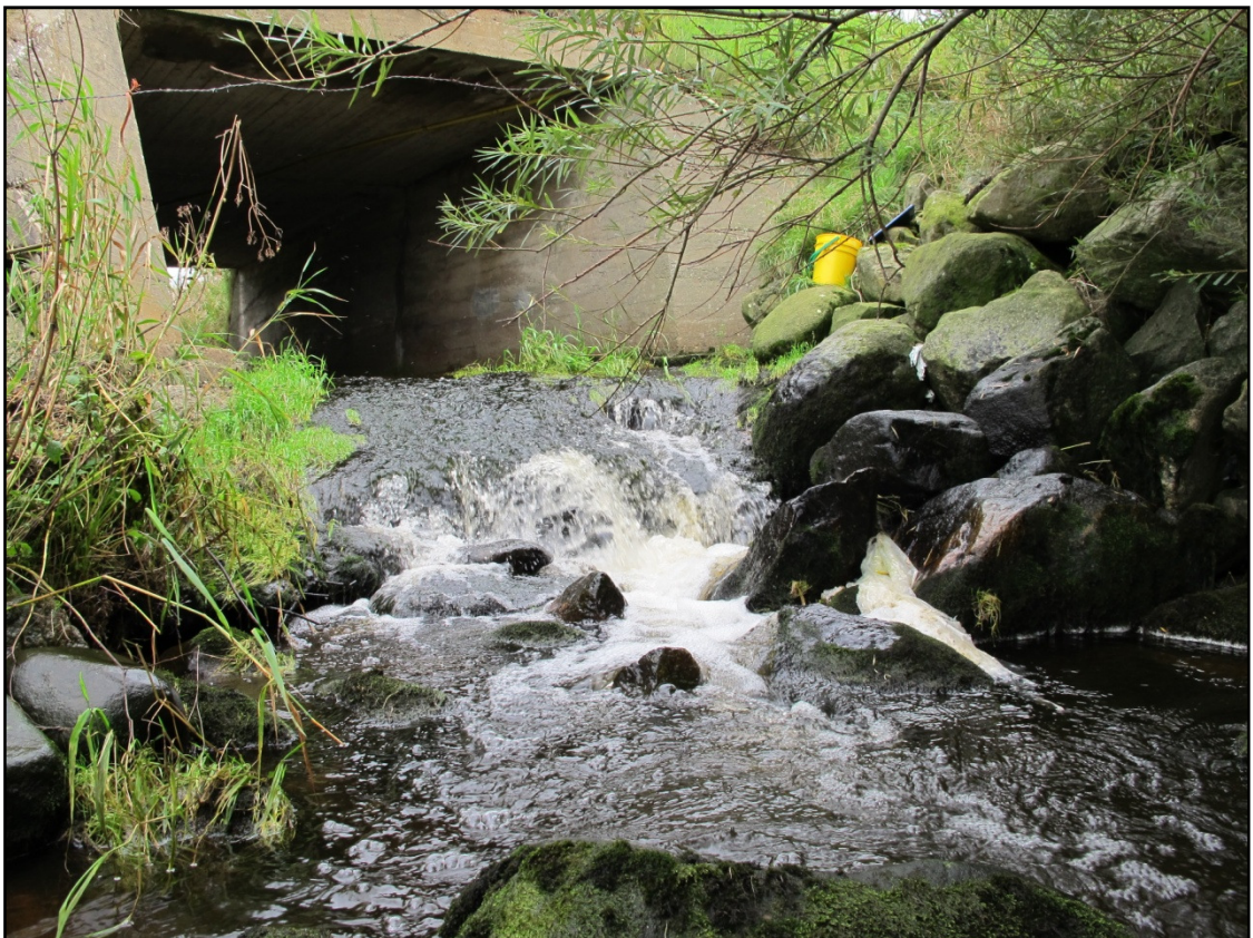
Figur 6.6. I tillegg til noe lav vannføring inne i kulverten så er det betongsklien nedstrøms, kombinert med fall i blokk som utgjør et vandringshinder i bekken.
